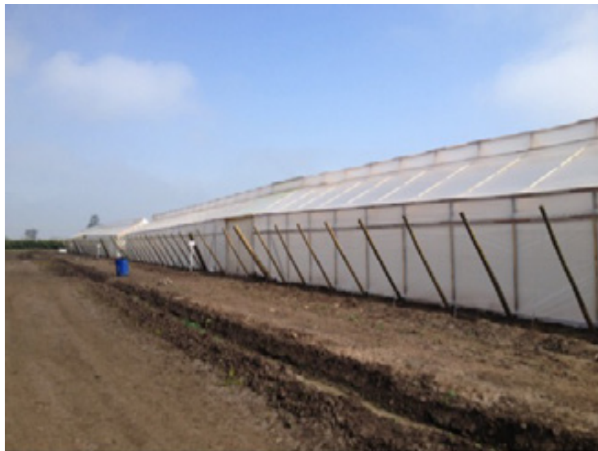
Imagen 2. Estructura de invernadero moderna en Quillota, Región de Valparaíso, con módulos unidos por pasillo central.
